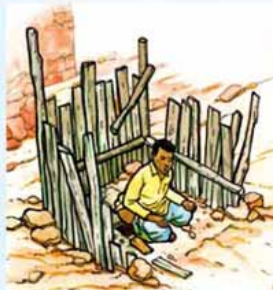
Dans une latrine à plancher artisanal en terre battue ou en bois, sans toit ni porte
